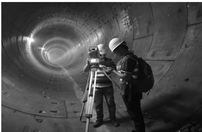
图3 盾构法区间隧道施工测量
