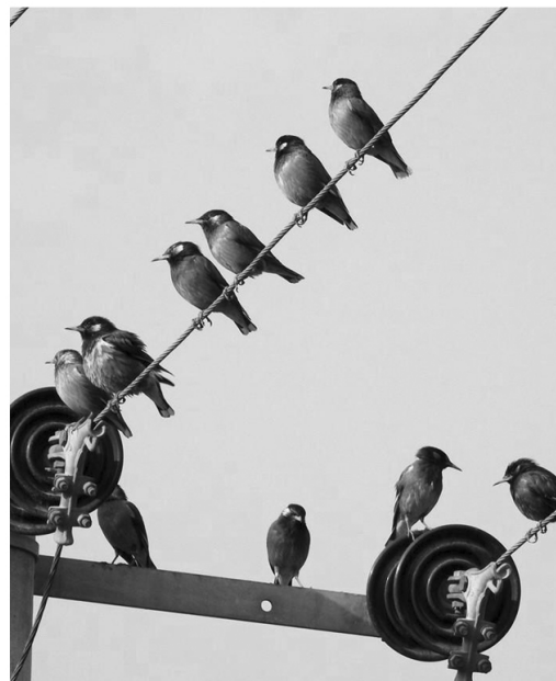
图1 鸟类栖息活动引发架空输电线路故障
