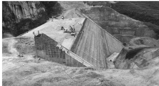
图 1 水利工程施工
